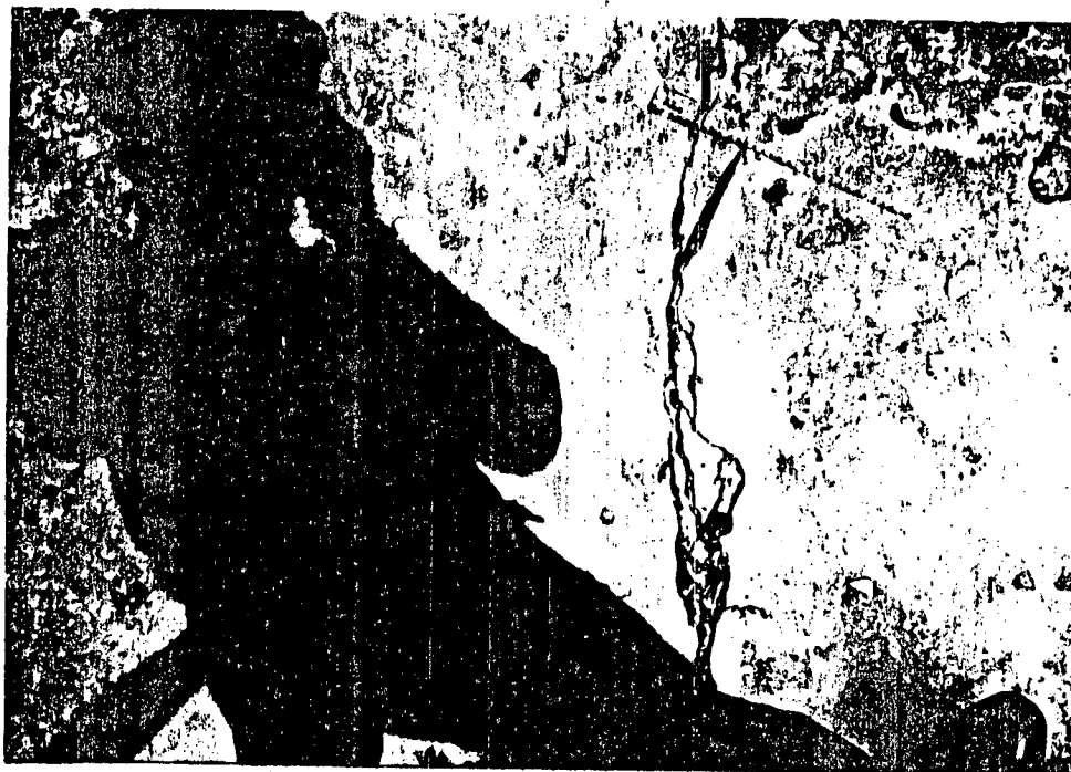
FOTO 9: Trinca no piso do quintal
